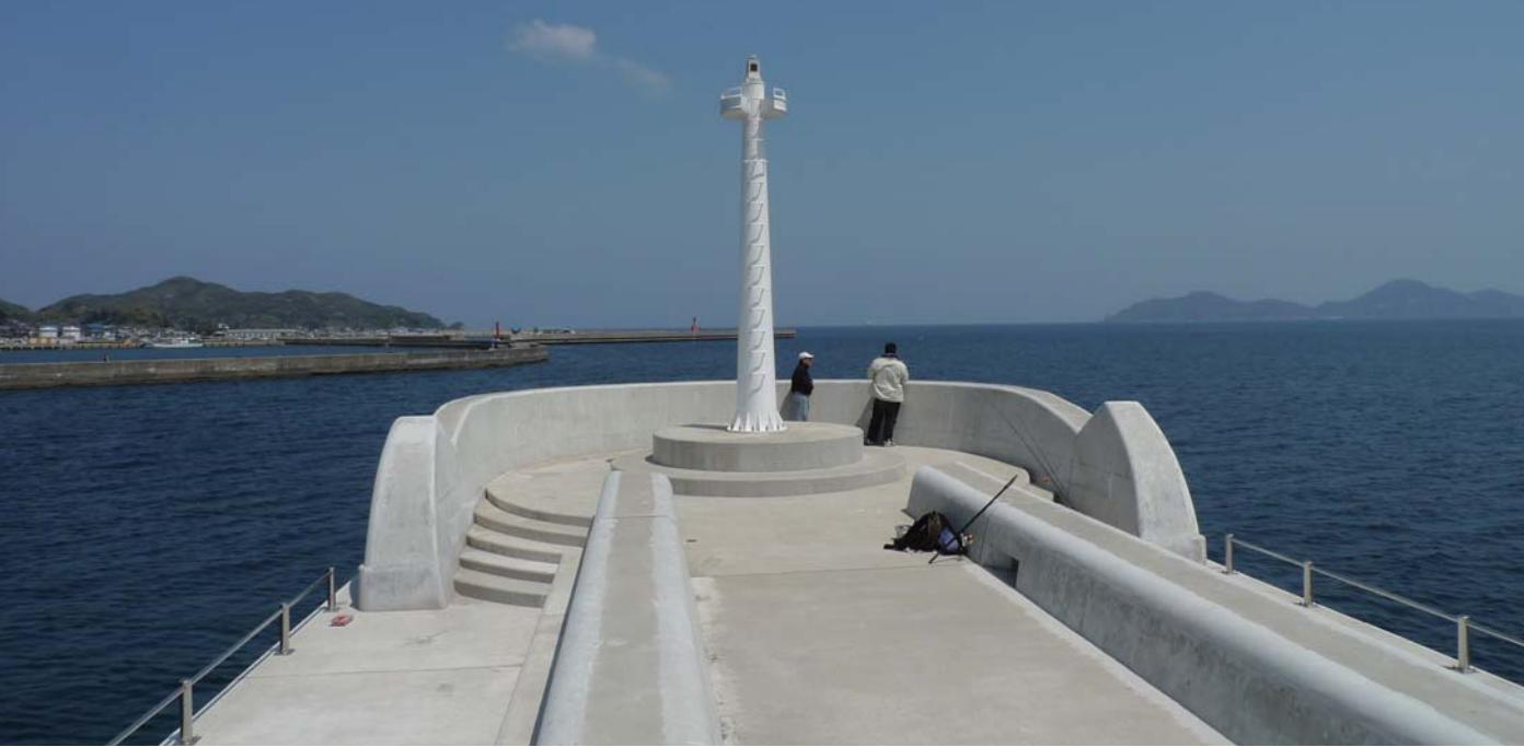
原案では鍵型で計画されていた遊歩道の線形を、後背の地形に合わせて曲線形のデザインに修正した。また歩道橋はシンプルにかつスレンダーに見えるよう地覆等の形状を検討し、雨水などの排水管や照明設備用の電気の配管等はすべて橋の内部に収納している。
